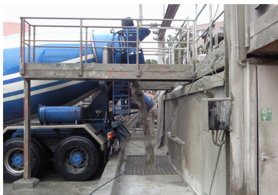
Canal d'amenée L'installation de nettoyage pour 4 camions-malaxeurs.
